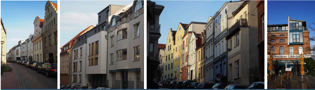
Bestandsfotos historischer Altstadtbereich
